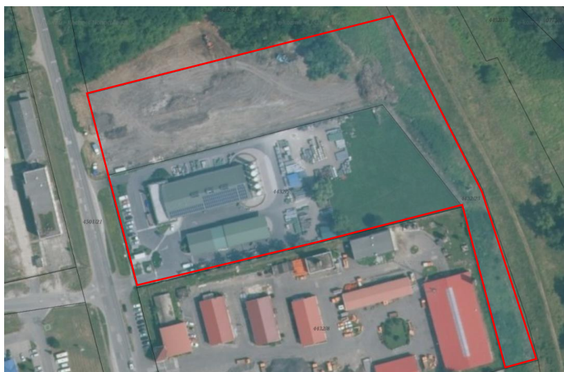
6. ábra: Légifelvétel a tervezett telekösszevonás ábrázolásával (ortofotó forrás: E-Közmű)
