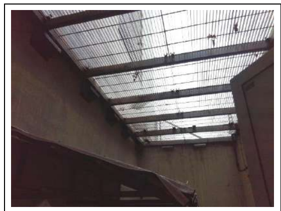
sósavtároló szabad födéme
