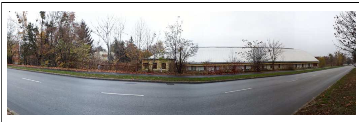
A vizsgált ingatlan nyugati telekhatára és a rajta épült befejezetlen tornacsarnok
