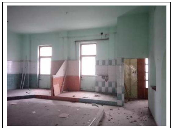
A keleti szárnyban lévő üzlet
