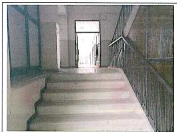
oktatási szárny - átjáró a „B” épületbe
