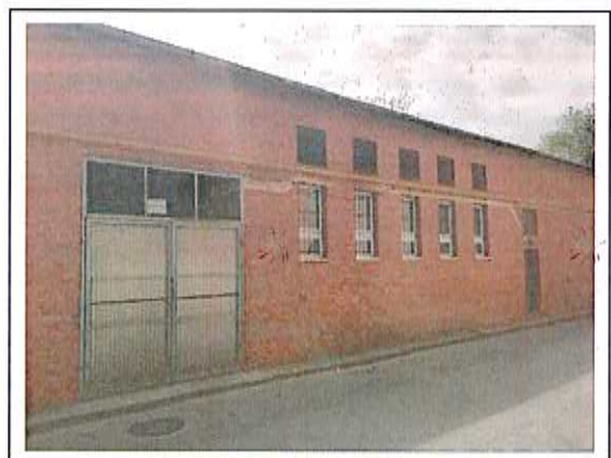
étterem-konyha északi homlokzat
