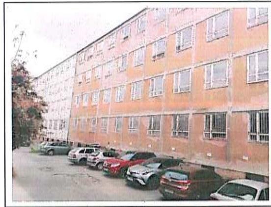
oktatási szárny északi homlokzat
