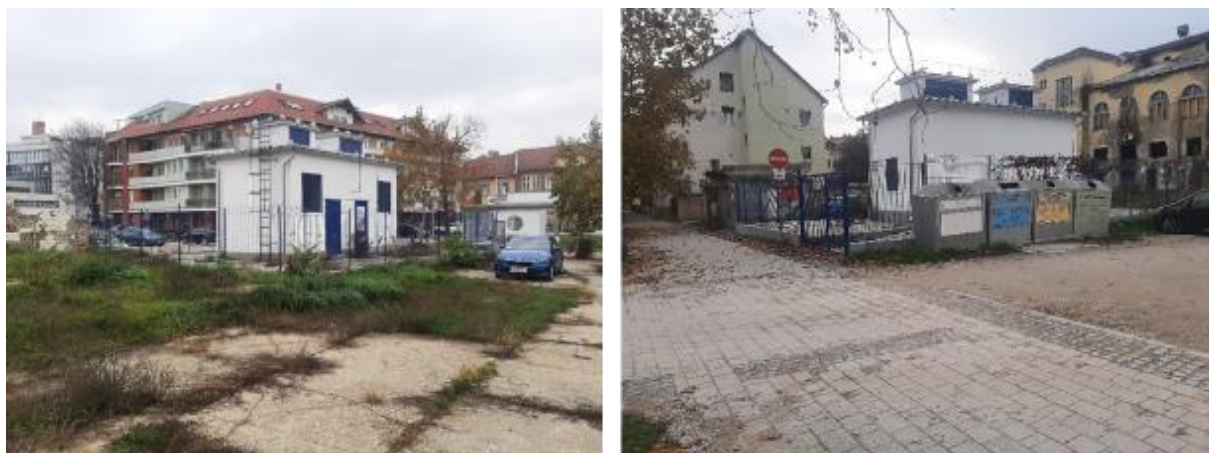
20. ábra: Gáznyomásszabályozó műtárgy (forrás: TSPC Kft.)
