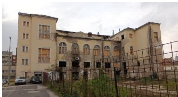
17. ábra: D épület északi része jelenlegi állapotában (forrás: TSPC Kft.)
