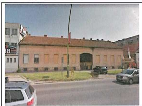
A főépület északi – utcai – homlokzata a főbejárattal
