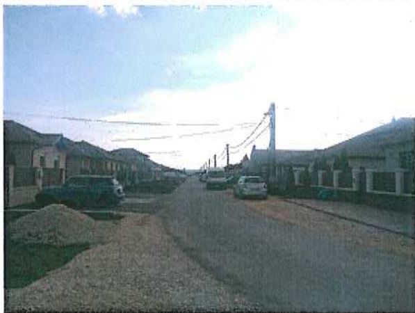
A Lajos Árpád utca kiépült szakasza
