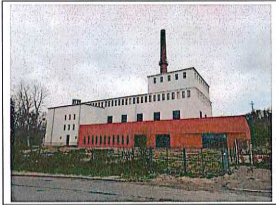
Az egykori fűtőmű épület tömege
