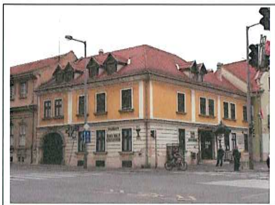
A vizsgált ingatlan utcai homlokzatai
