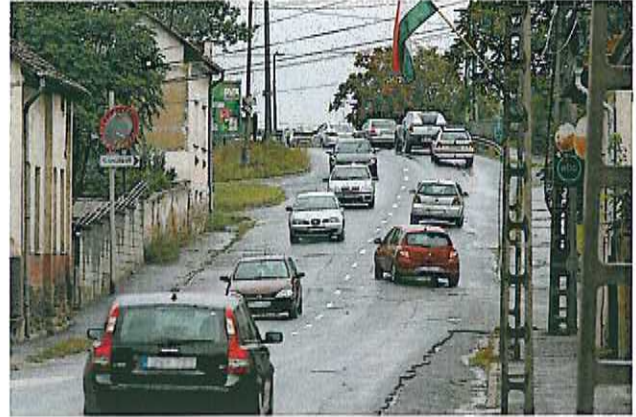
A Kisfaludy úti felüljáró csúcsforgalmi terhelése a lezárást megelőzően.
