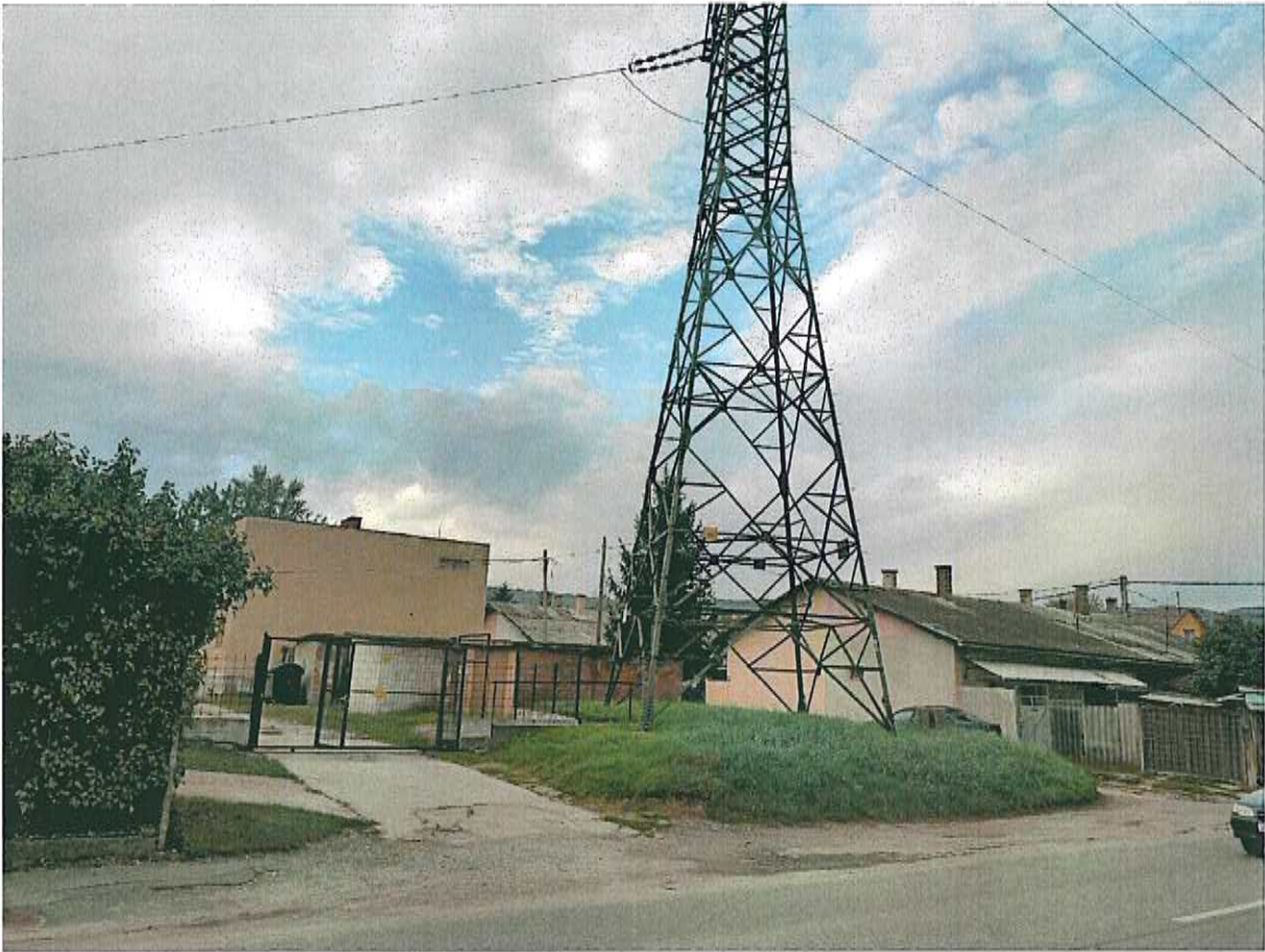
3. ábra: A 23504/7 hrsz.-ú társasház, mögötte a 23504/8 hrsz.-ú ingatlanon meglévő festő üzem.
