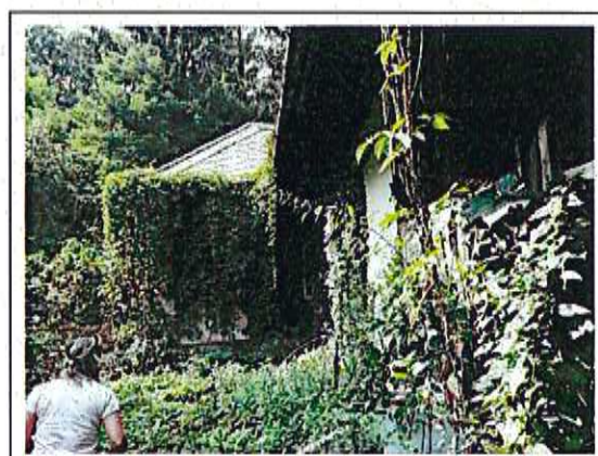
A bontásra szoruló épület udvari homlokzata
