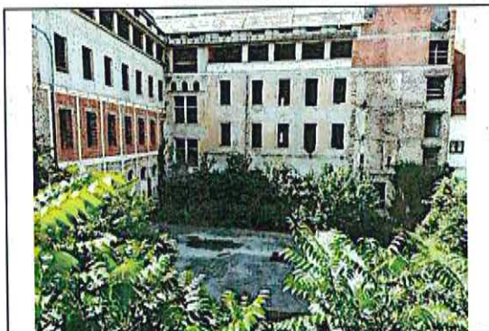
Az „A” épületrész udvari homlokzata
