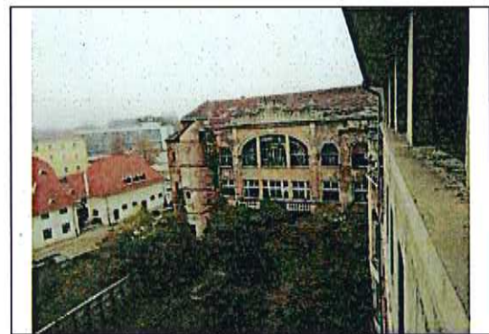
A nyugati szomszéd épület és a „D” épületrész udvari homlokzata
