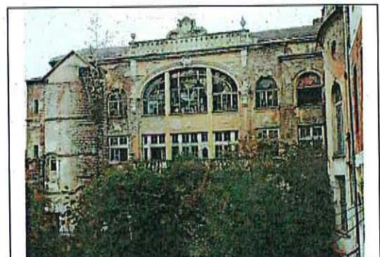
A „D” épületrész udvari homlokzata
