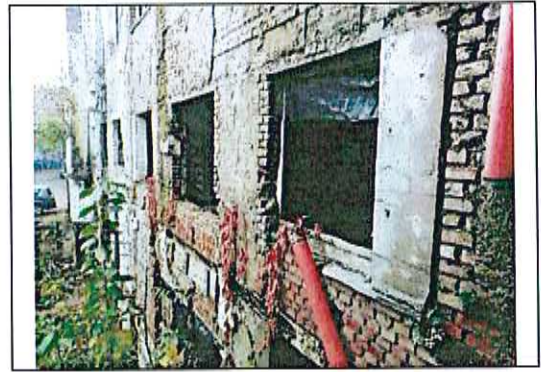
A „D” jelű épület északi homlokzata
