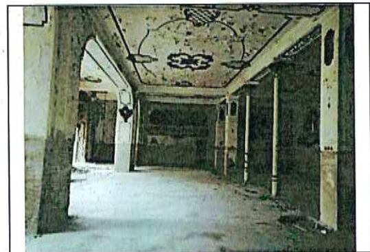
„D” épületrész földszint – a volt Fehér terem
