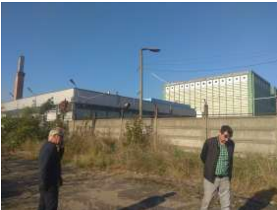
A szomszédos ingatlanon üzemelő hűtőház...
