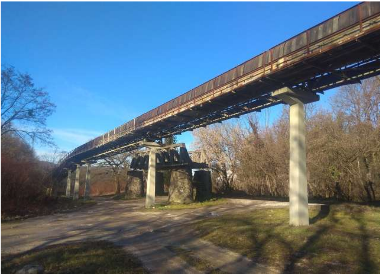
A szállítószalag és két oldali szervízútja a 2. sz. tervezési területen
