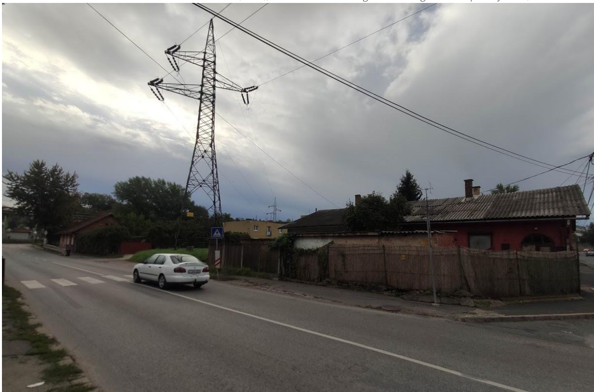
5. ábra: A 23504/1 lakóépület (balra), 23504/7 hrsz.-ú társasház (középen), 23504/7 hrsz.-ú ingatlanon meglévő lakóépület (jobbra).
