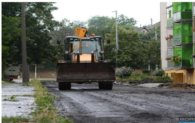
5. ábra – kerékpárút építése
