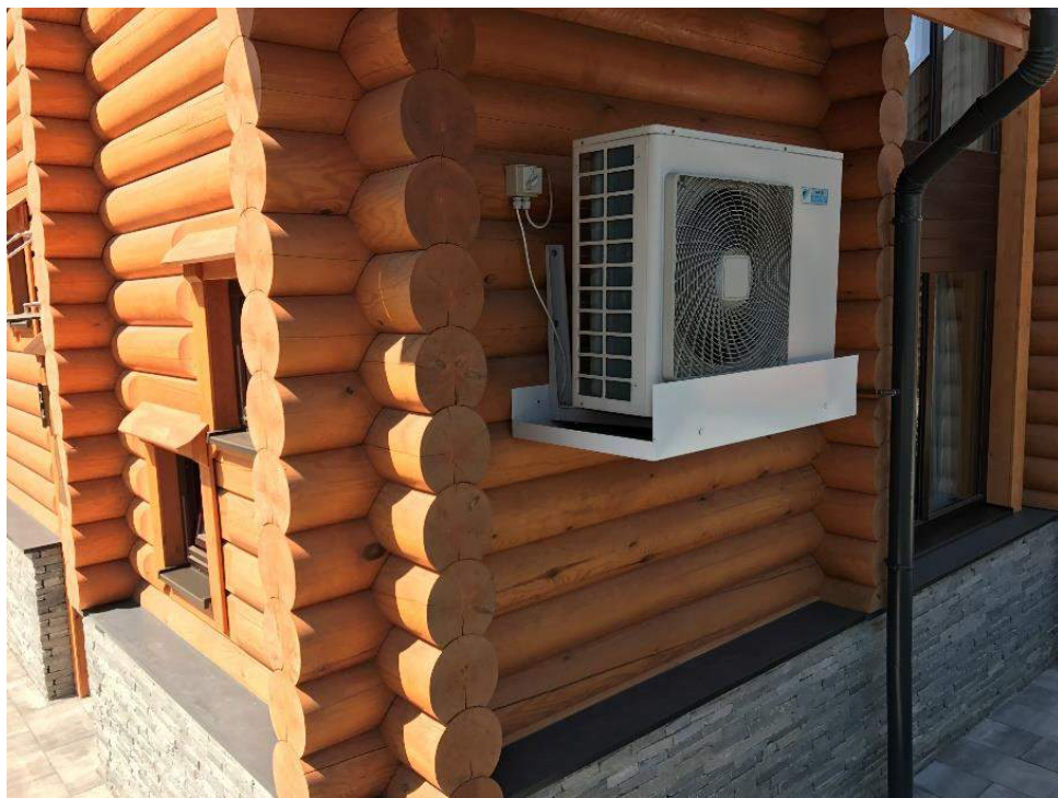
OLDALHOMLOKZATON JÓL ELHELYEZETT KLÍMABERENDEZÉS, KAMERA ILLETVE VILÁGÍTÓTEST TAPOLCÁN
