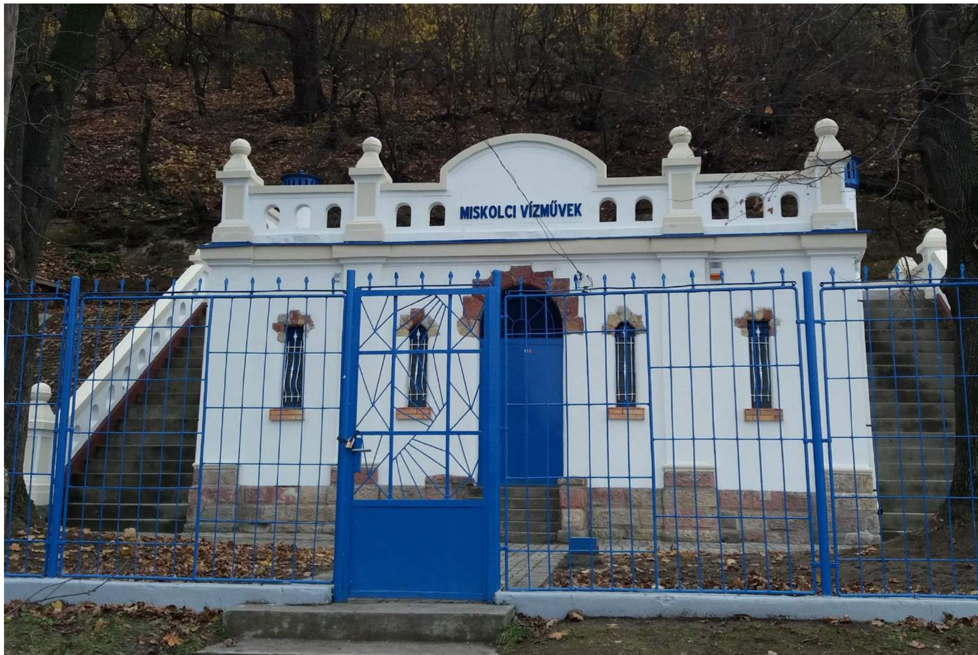
MISKOLCI VÍZMŰVEK ÉPÍTMÉNYE A NAGYVÁSVÁZON
