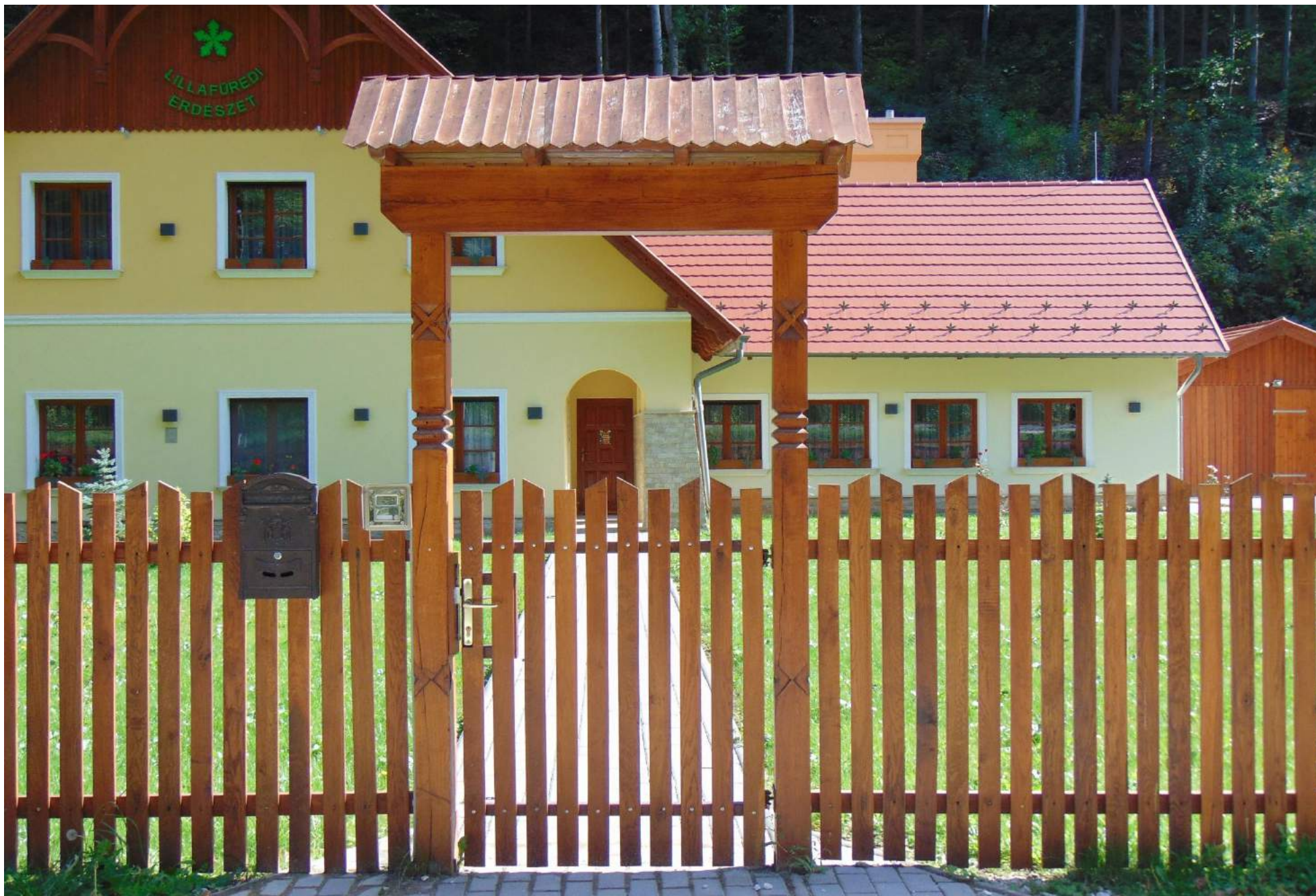
IGÉNYES, ÉPÍTETT ÉS TÁJI KÖRNYEZETHEZ ILLŐ LÉCKERÍTÉS LILLAFÜREDEN
