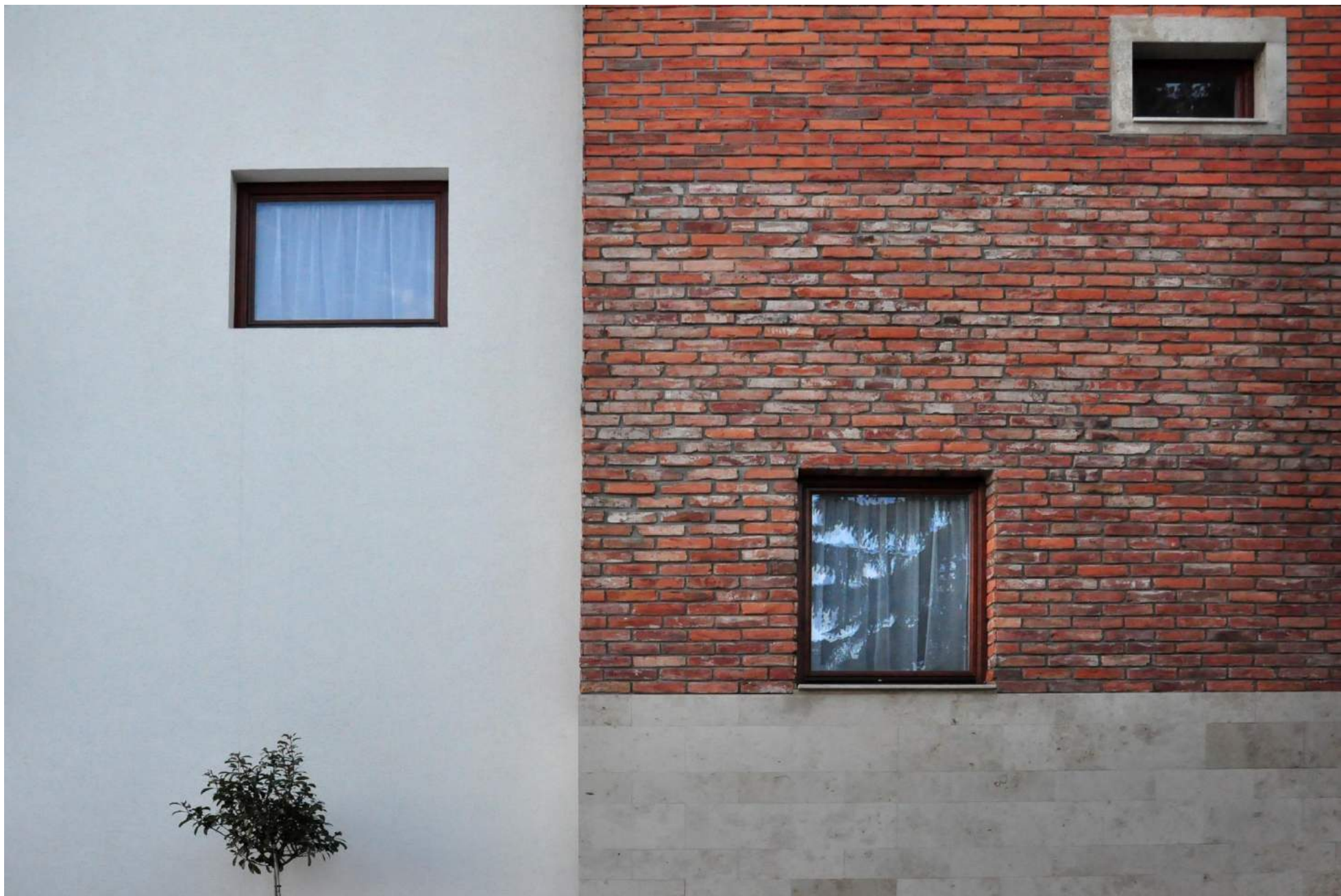
ELTÉRŐ FELÜLETEK TALÁLKOZÁSA EGY TAPOLCAI CSALÁDI HÁZ HOMLOKZATÁN
