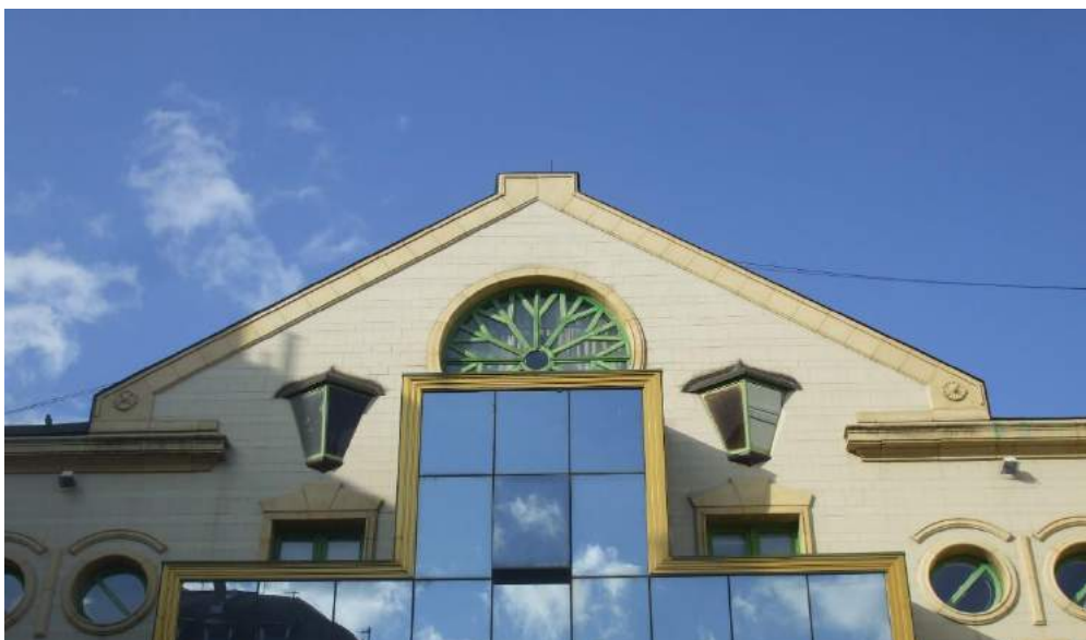
SZÍNHÁZTÖMB MŰVÉSZBEJÁRÓJÁNAK HOMLOKZATA
